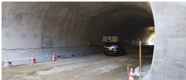
<車載計測装置によるトンネル計測状況>
