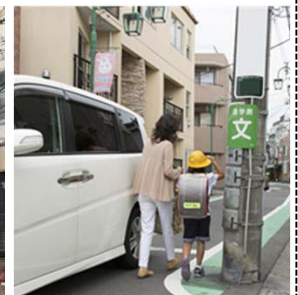
<歩行の支障となる電柱の事例>
