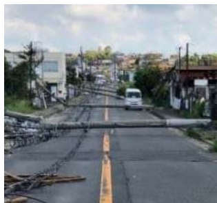
<電柱の倒壊による道路閉塞の事例>
