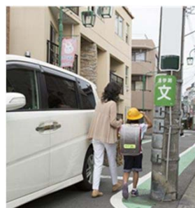
<歩行の支障となる電柱の事例>
