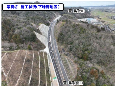
工事状況写真
