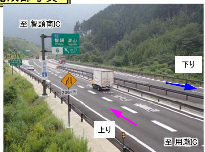
写真① 智頭IC上り線 (R2.6完成)
