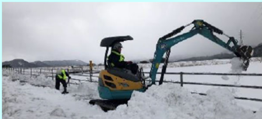
パワーショベルによる歩道除雪 (古海地区)
