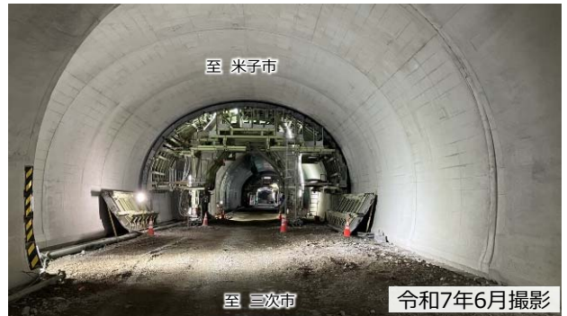
【写真①】 覆工コンクリートの施工状況
