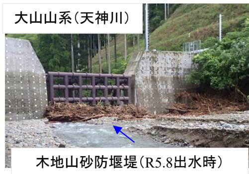
土砂・流木捕捉事例
