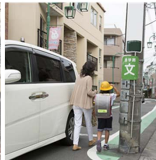
<歩行の支障となる電柱の事例>
