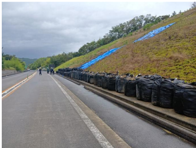
応急復旧状況
