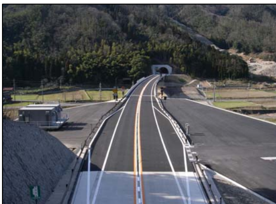
鳥取自動車道用瀬舗装工事
