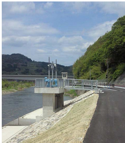
②樋門整備状況
