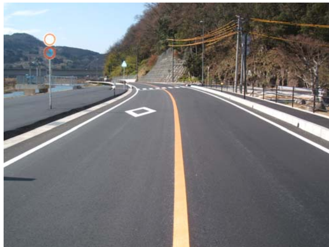
①岡山側から全景撮影
