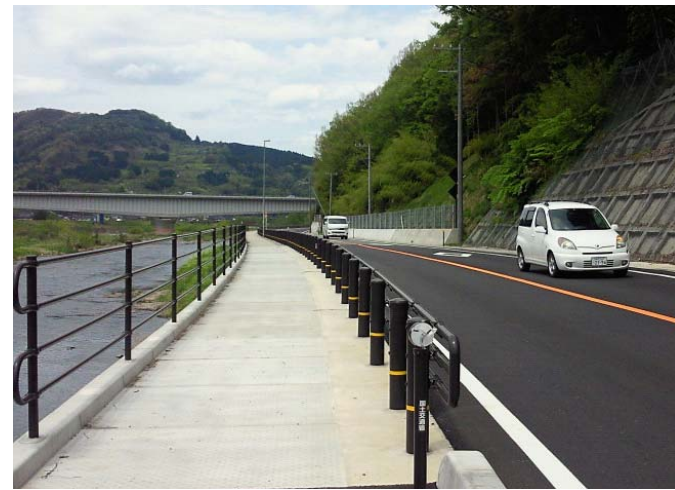
③歩道整備状況
