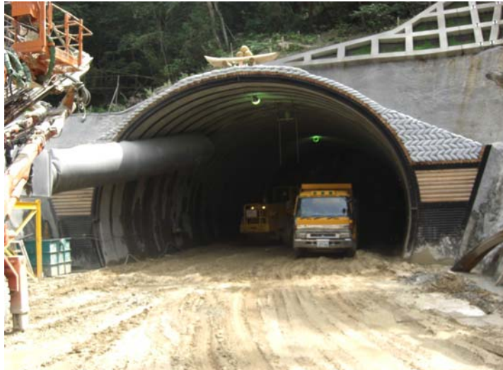
トンネル坑口
