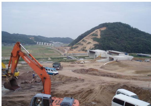
鳥取IC付近の施工状況
