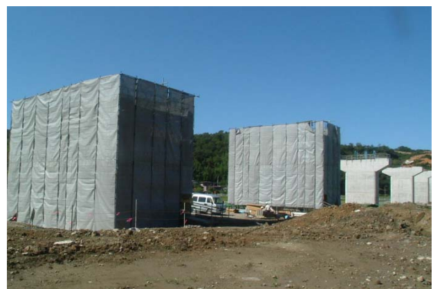
本高高架橋(橋梁下部工事)
