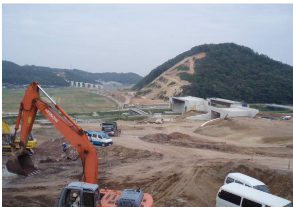
鳥取IC付近の施工状況
