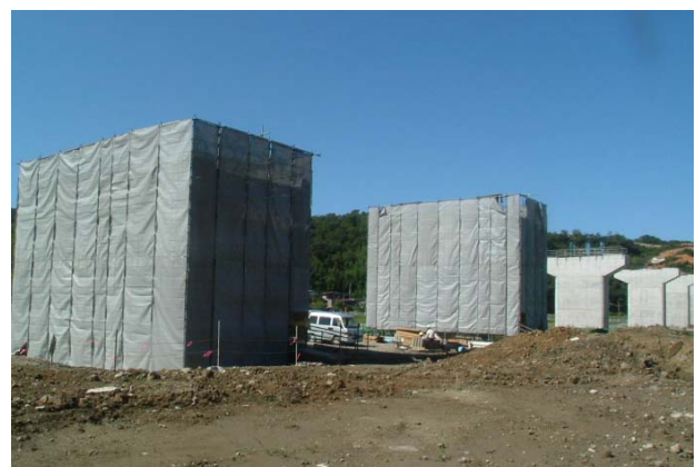
本高高架橋(橋梁下部工事)
