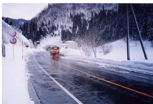
戸倉トンネル坑口付近
