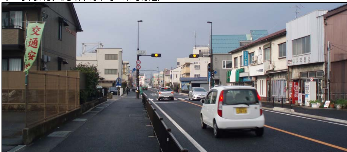
○工事完成後（鳥取市材木町・東町付近）
