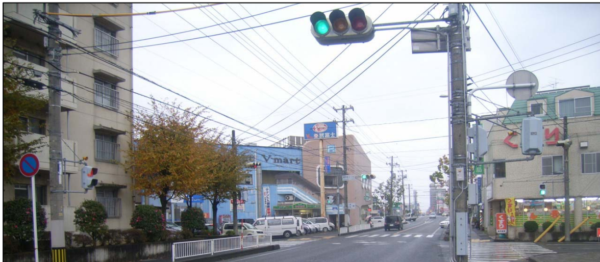
○工事完成前（鳥取市材木町・湯所町付近）
