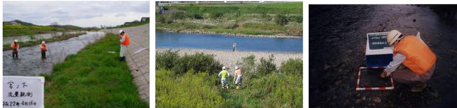
低水流量観測(年36回) 縦横断測量(5年以内に1回) 河床材料調査(縦横断測量時)
