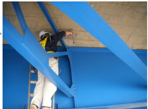
永江川橋(上り)
