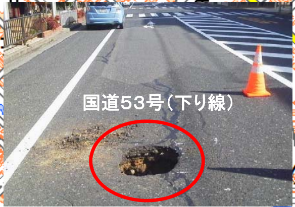
【写真1】路面陥没状況
