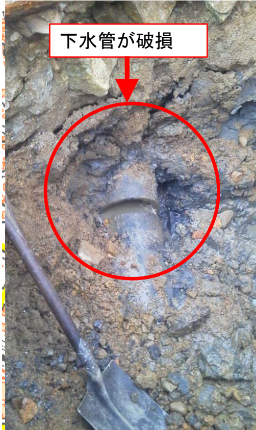
【写真2】陥没箇所 掘削状況
