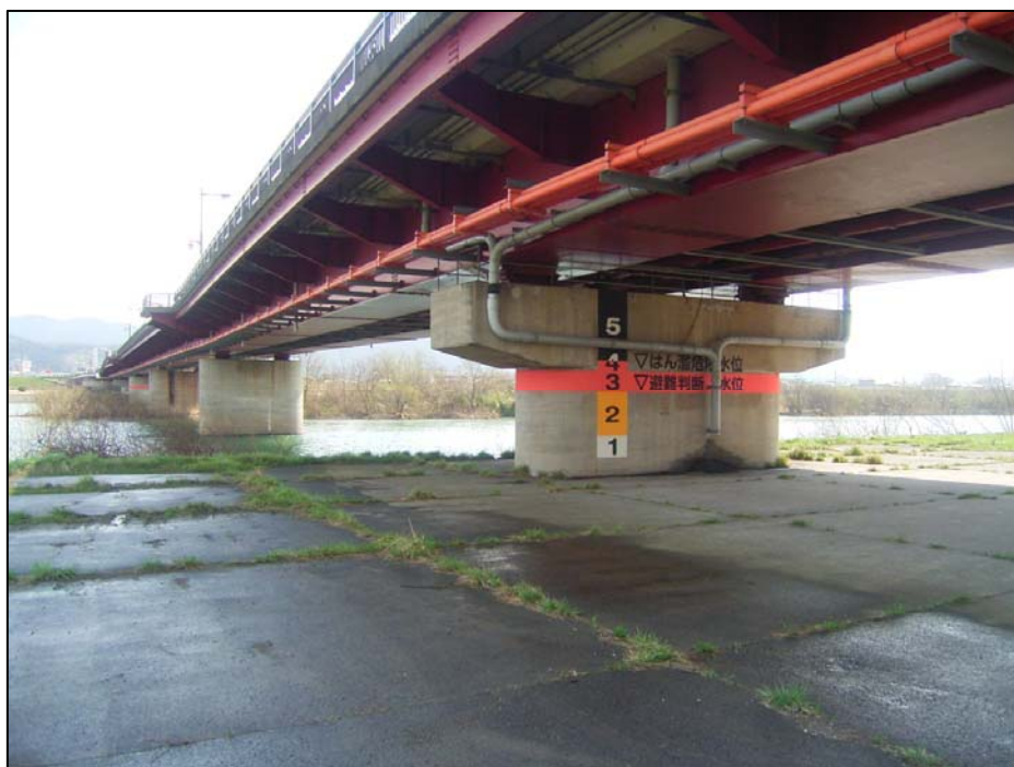
○千代川 八千代橋左岸 橋脚水位表示
