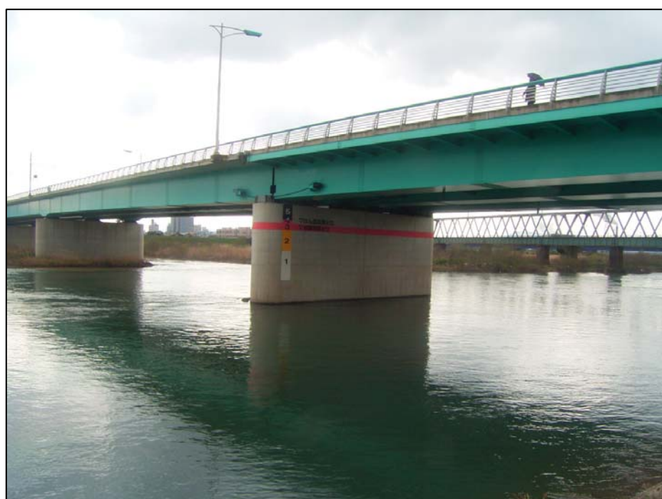
○千代川 新千代橋左岸 橋脚水位表示
