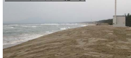
サンドリサイクル施工後
