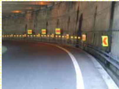
視線誘導のための反射板の更新
