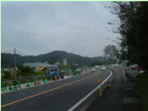
29号八頭町下坂右折レーン設置工事
