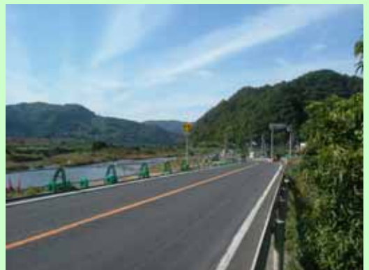
53号河原町釜口歩道設置工事
