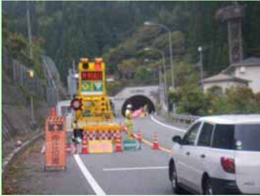
29号戸倉トンネル融雪装置設置工事
