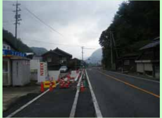
29号若桜町浅井歩道設置工事
