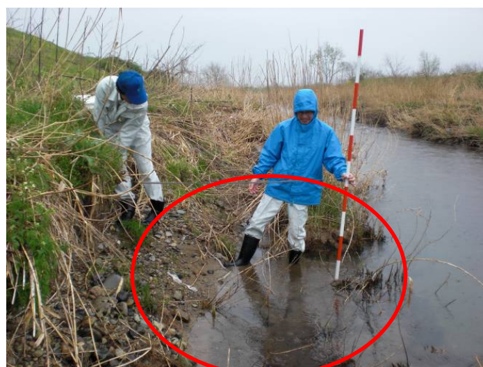
砂見川合流点 河床が一部洗掘 (出水時に変化をモニタリング)
