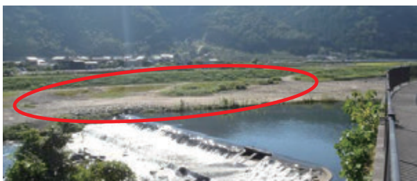
平成26年度工事実施状況(鳥取市河原町八日市箇所)
