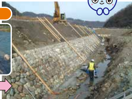
(護岸損傷)
