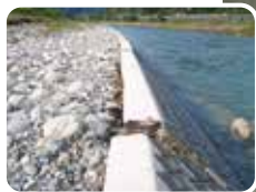
(護岸損傷)
