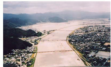
H2年9月台風19号による円山川周辺の浸水状況
