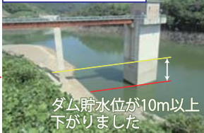
ダム貯水位が10m以上 下がりました 渇水時に貯めた水を流します。 (平成29年7月)
