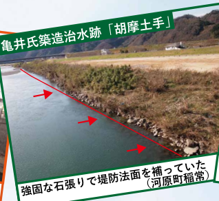
川の合流部のため、激しく流れる水の勢いを弱めるために設けられた(河原町袋河原付近)
