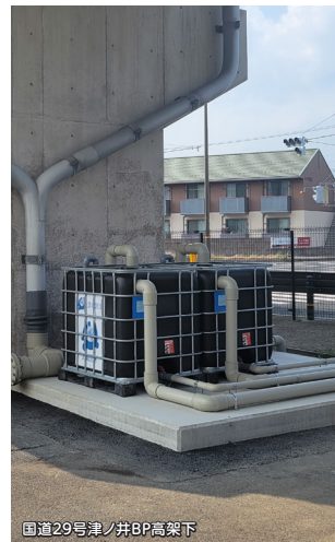
国道29号津ノ井BP高架下
