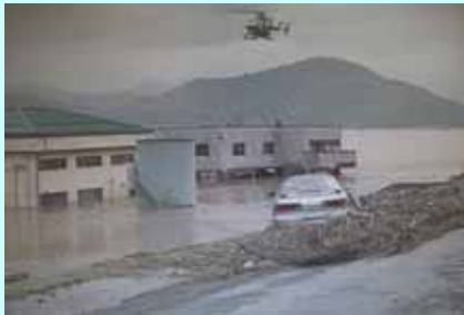
円山川の破堤箇所付近 (兵庫県豊岡市)
