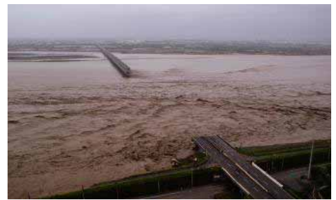
写真18 洗掘等により倒壊した橋梁
