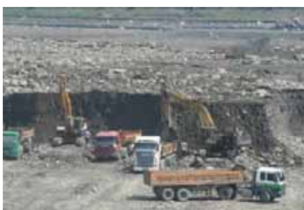
新威大橋付近土砂堆積
