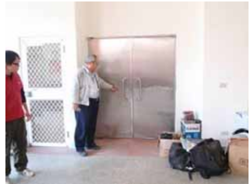
写真5 寶來村での天然ダム決壊による浸水被害
