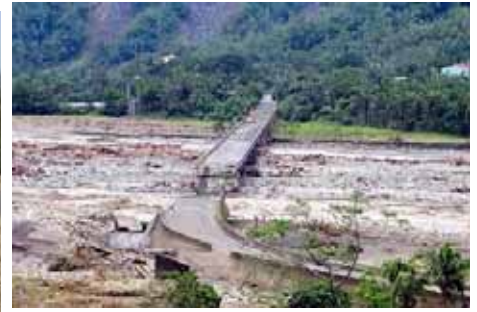
写真16 取付部が破壊された橋
