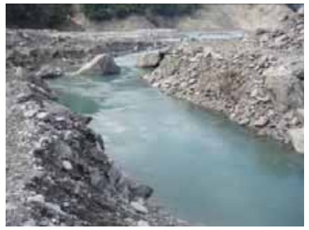
写真12 天然ダムに設置された排水路
