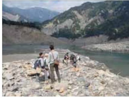
写真11 深層崩壊による天然ダム
