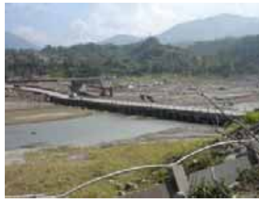
写真17 鋼管杭製橋脚の座屈状況
