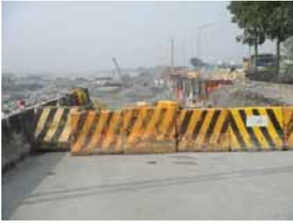
写真7 道路1車線分の侵食
