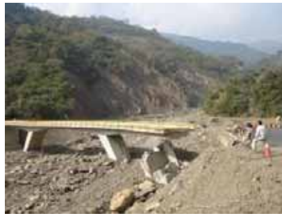
写真15 橋台のみが破壊された橋
