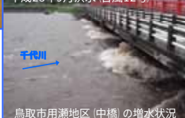
鳥取市用瀬地区(中橋)の増水状況
