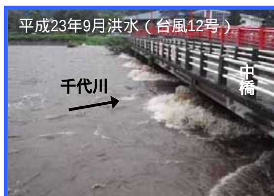
鳥取市用瀬地区（中橋）の増水状況
