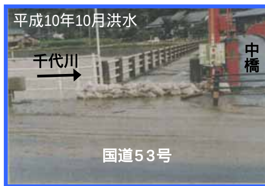
鳥取市用瀬地区（中橋）の増水状況
