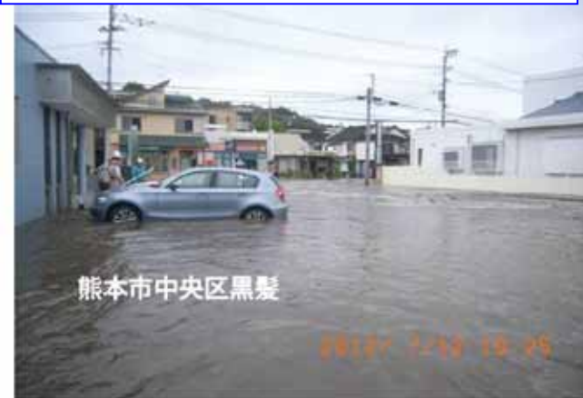
小碓橋下流右岸の越水状況(7/12 10:25)
