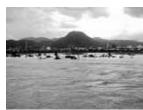
平成 16 年 9 月洪水 源太橋付近
