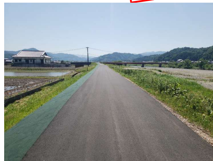
R4施工箇所：八東川（八頭町）
