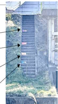
樋門横階段に目安を表示 (地区の集会所から視認可能)
