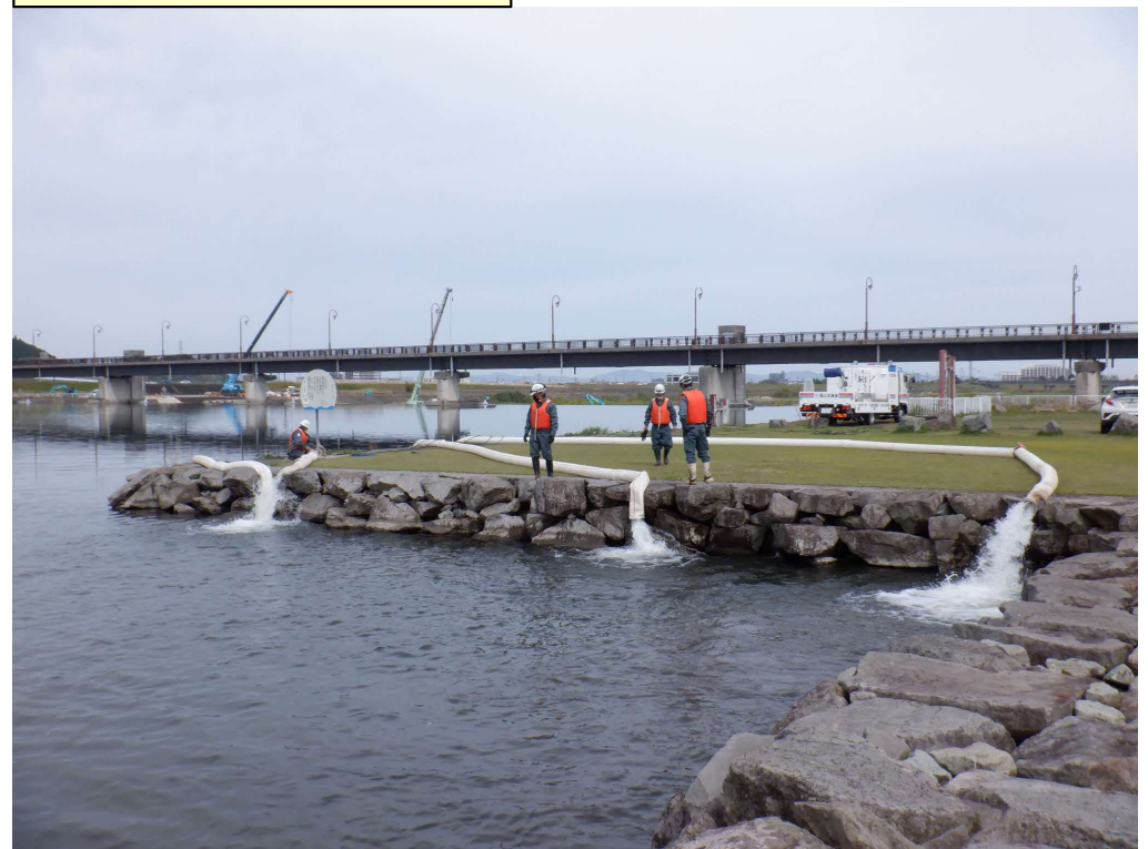
排水ポンプ車訓練(令和5年度)
