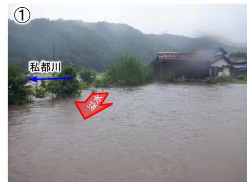
▲農地浸水の状況
