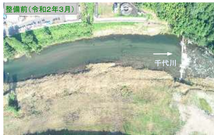
用瀬町美成地区 整備状況(23k200付近)
