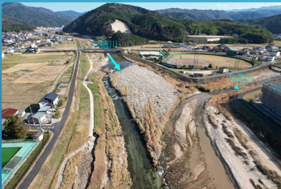
土砂堆積状況
