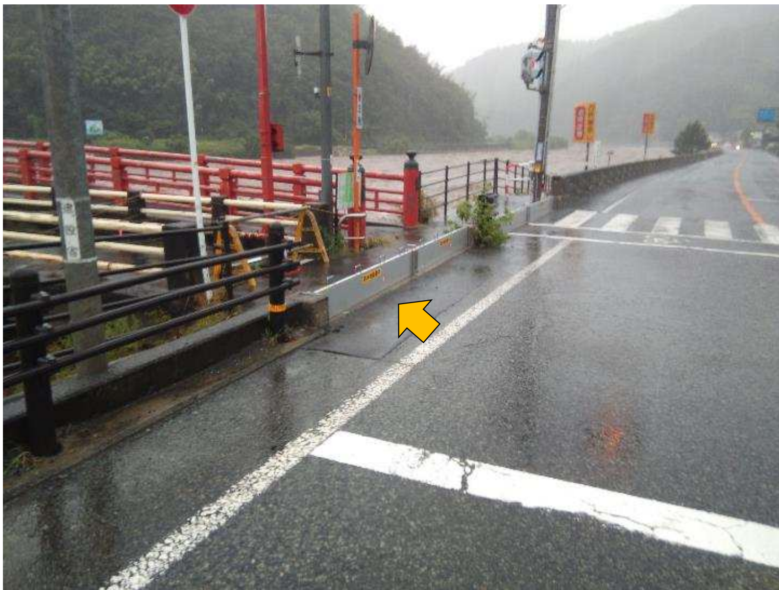
用瀬陸閘門設置状況
