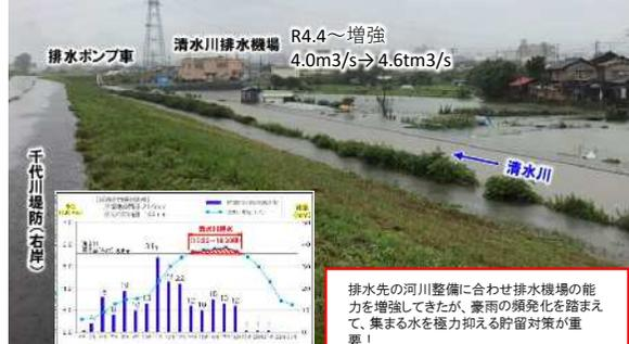
排水先の河川整備に合わせ排水機場の能力を増強してきたが、豪雨の頻発化を踏まえて、集まる水を極力抑える貯留対策が重要!
