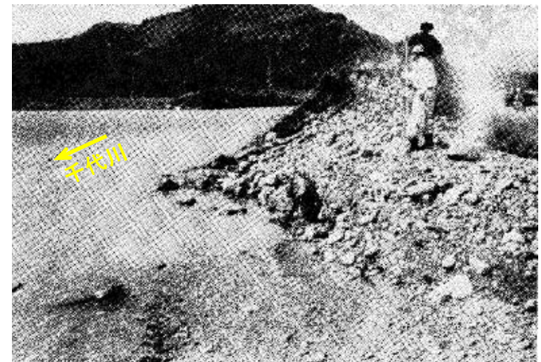
破堤状況(鳥取市河原町/曳田川合流点付近)
