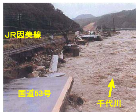
河岸浸食状況 (鳥取市用瀬町鹿の子)
