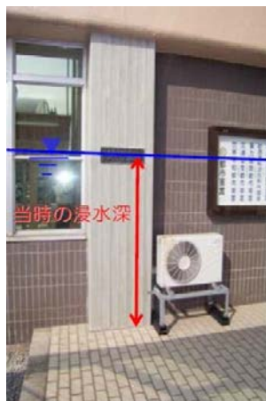
←鳥取市役所玄関前洪水進入線 TP 7.22m 路面上約3.0m
