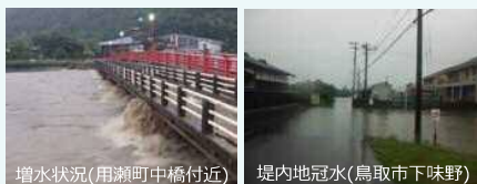
増水状況(用瀬町中橋付近) 堤内地冠水(鳥取市下味野)
