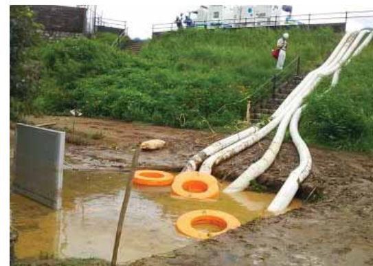
参考) 排水ポンプ車の釜場の状況
