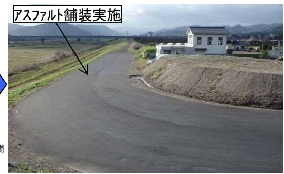
舗装後の堤防天端状況
