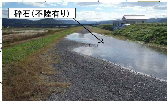
舗装前の堤防天端状況
