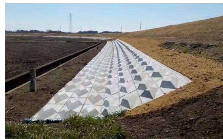
法尻補強の事例(久慈川)
