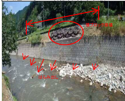
【道路兼用護岸損壊】L=38m 国道53号 八頭郡智頭町早瀬
