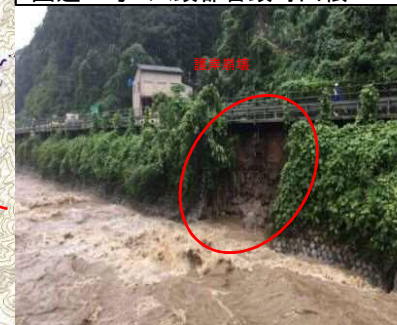
【道路兼用護岸損壊】L=30m 国道53号 八頭郡智頭町山根
