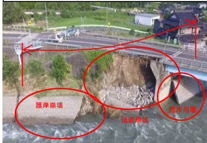
【道路兼用護岸損壊】L=54m 国道53号 鳥取市用瀬町古用瀬
