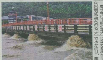
橋のすぐ下まで増水した国道53号沿いの千代川。7日、鳥取市用瀬町用瀬
