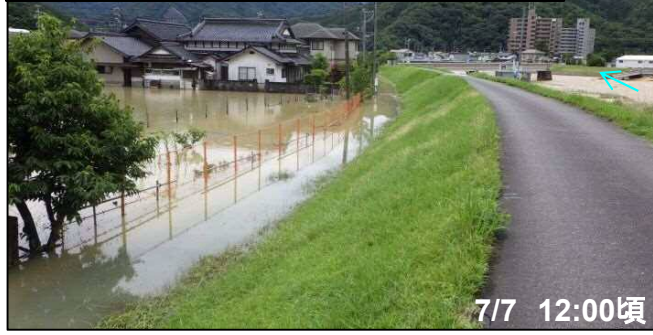
【溢水】三篠川左岸6k000付近(広島市安佐北区)
