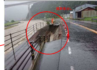
【道路兼用護岸損壊】L=40m 国道53号 八頭郡智頭町市瀬
