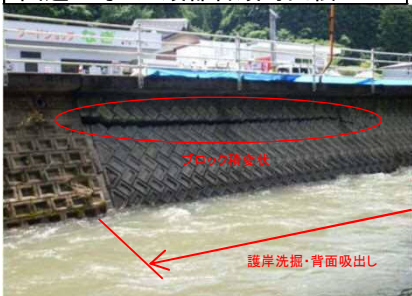
【道路兼用護岸損壊】L=38m 国道53号 八頭郡智頭町早瀬
