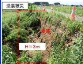
天端のアスファルト等が、越水による侵食から堤体を保護(响瀬川水系吉田川、平成27年9月関東・東北豪雨)
