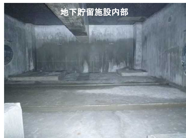
雨水貯留浸透施設の事例【横浜市内】
