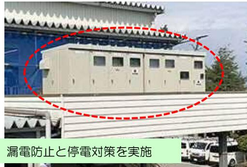
② 制御装置の高床化、停電に備え受電変圧施設の高床化
