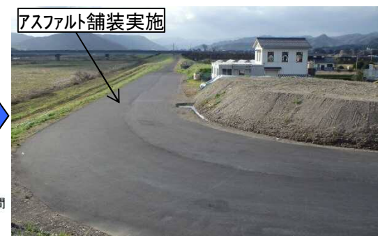
舗装後の堤防天端状況
