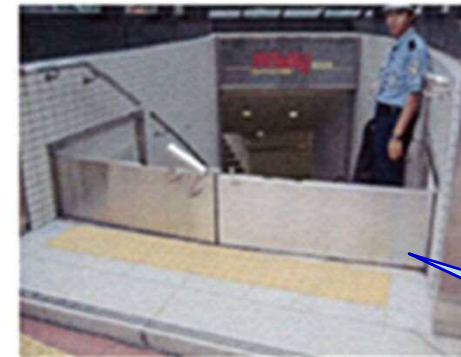
止水板、水防扉の設置
