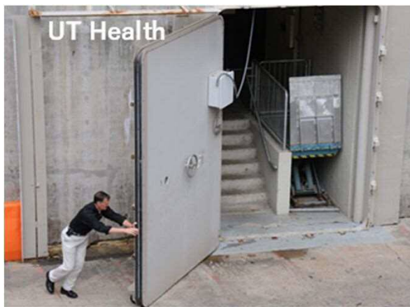
① 浸水の伝搬防止を目的とした出入口及び地下空間への防水扉の設置
