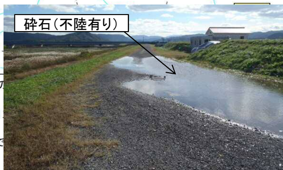
舗装前の堤防天端状況
