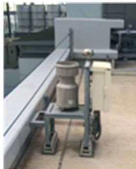
屋上へ雨量計設置
