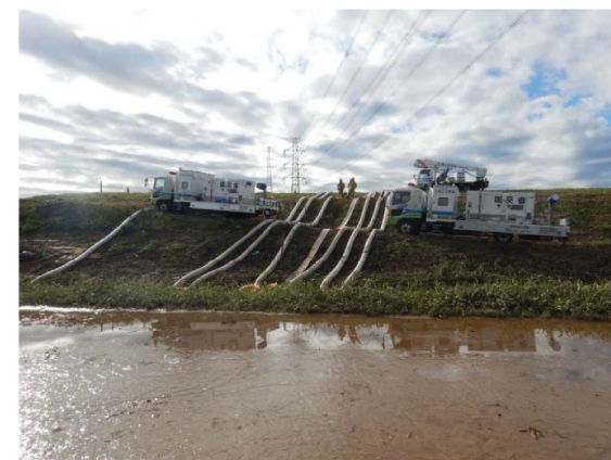
排水ポンプ車による排水作業(応急対策班)
