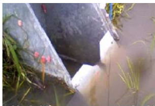
落水口へ専用堰板設置
