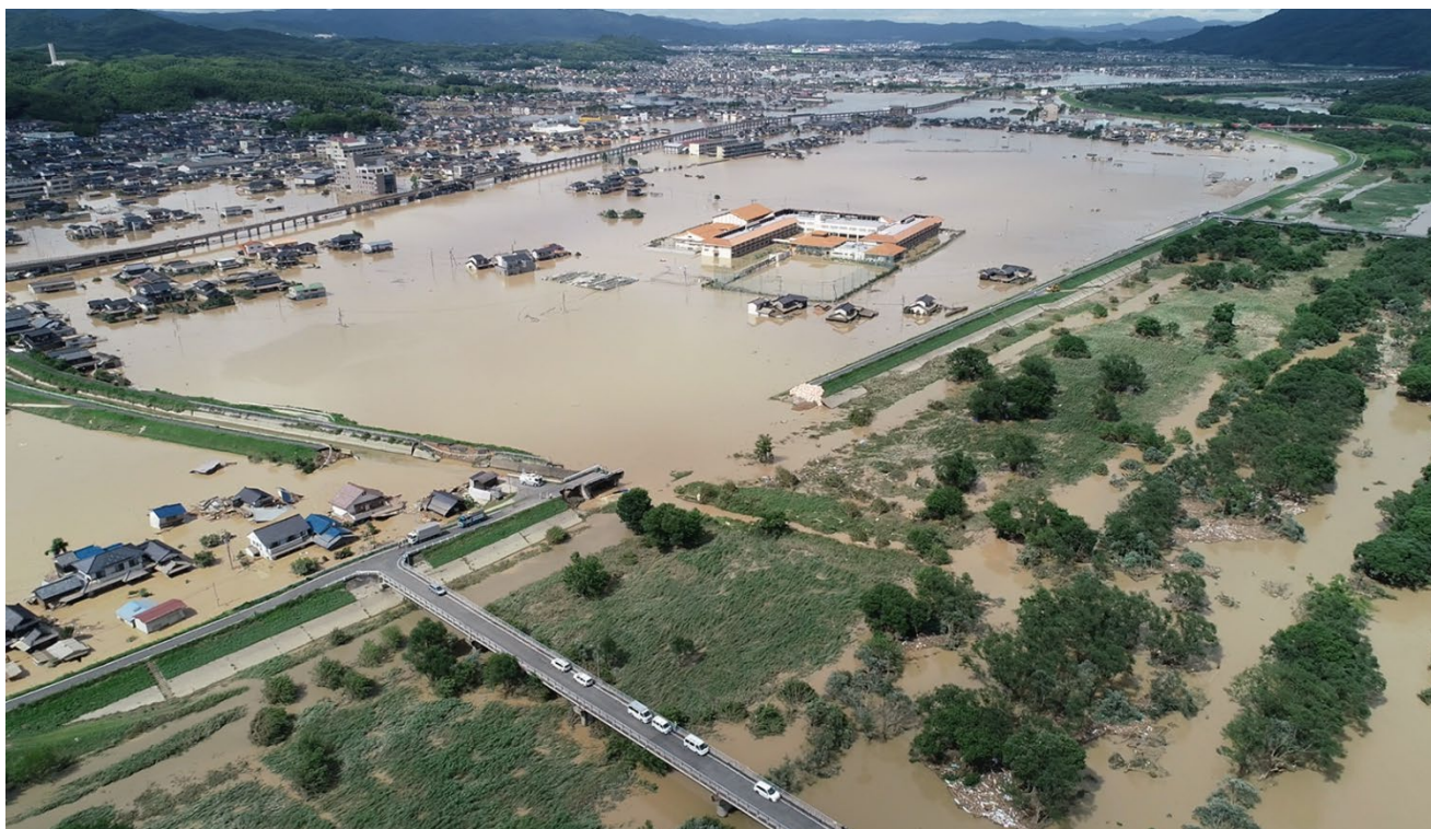
平成30年7月豪雨による小田川（岡山県倉敷市真備町）堤防決壊
