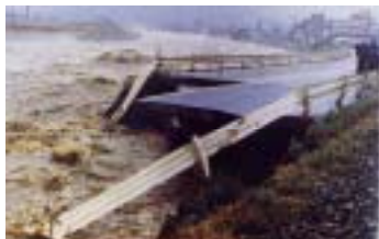
国道が侵食により流出(旧用瀬町: 現鳥取市)
