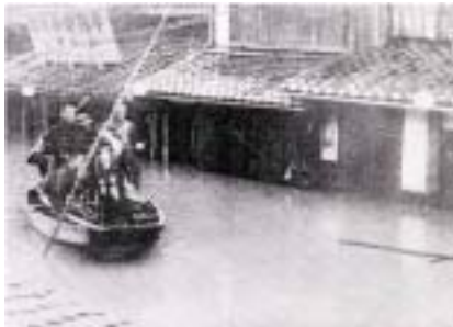
千代川下流部の破堤氾濫
