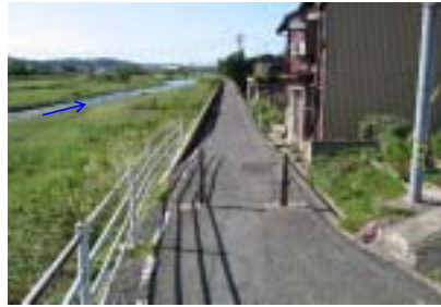
堤防の嵩上げが必要な宮ノ下地区右岸(袋川)
